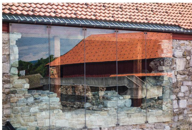
شکل ۲-۱۶- وضعیت لایه‌لایه‌شده در نمای بیرونی با شیشه بدون قاب که به دیوار سنگی تاریخی متصل شده است. منبع: عکس از برایان شیلدرز.
