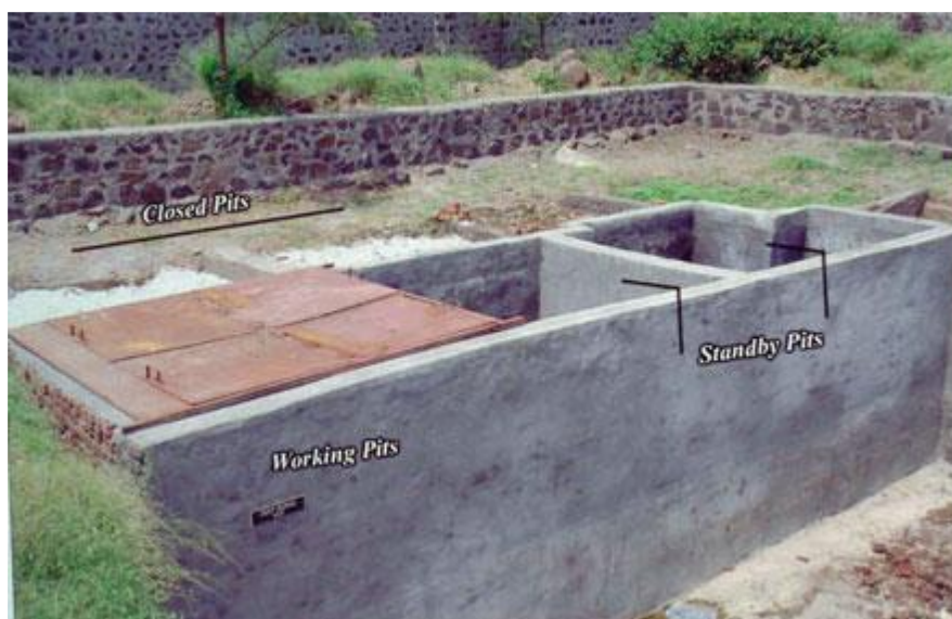
شکل ۶-۱۵ ساختمان دفن عمقی پسماند زیست پزشکی
