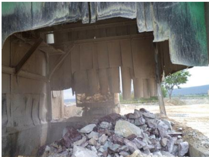
شکل ۹-۷ خوراک دهنده به دستگاه خردکن در واحد سنگ معدن
