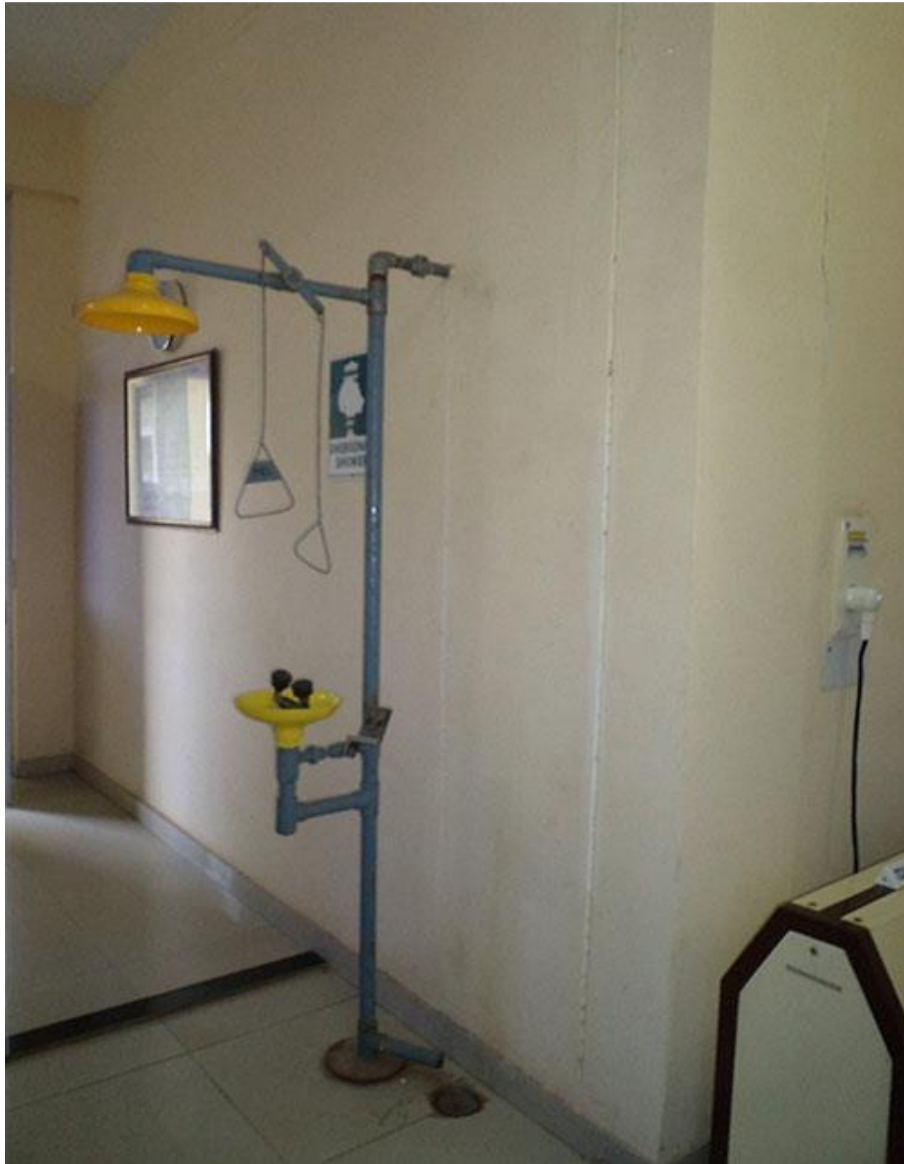
شکل ۱۱-۱۳ سیستم شست و شوی چشم و دوش اضطراری در مرکز TSDF پسماند خطرناک
