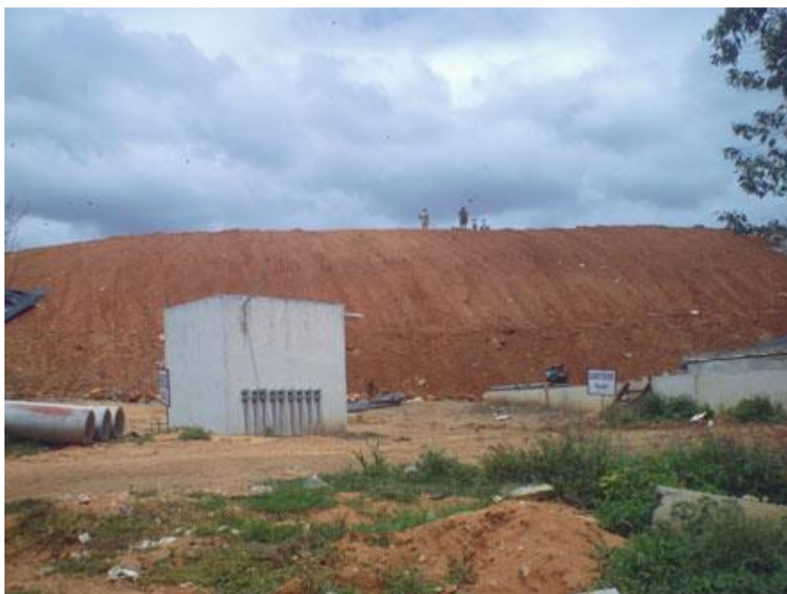
شکل ۵-۱۴ پوشاندن خاک رس با خاک معمولی در سرپوش لندفیل
