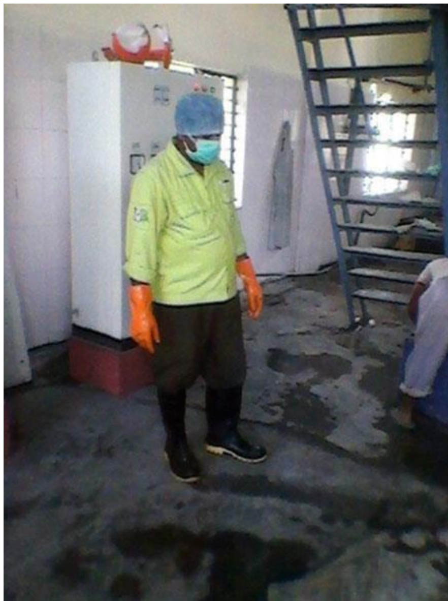
شکل ۱۱-۱۸ تجهیزات محافظت شخصی در تأسیسات تصفیه پسماند بیوپزشکی
