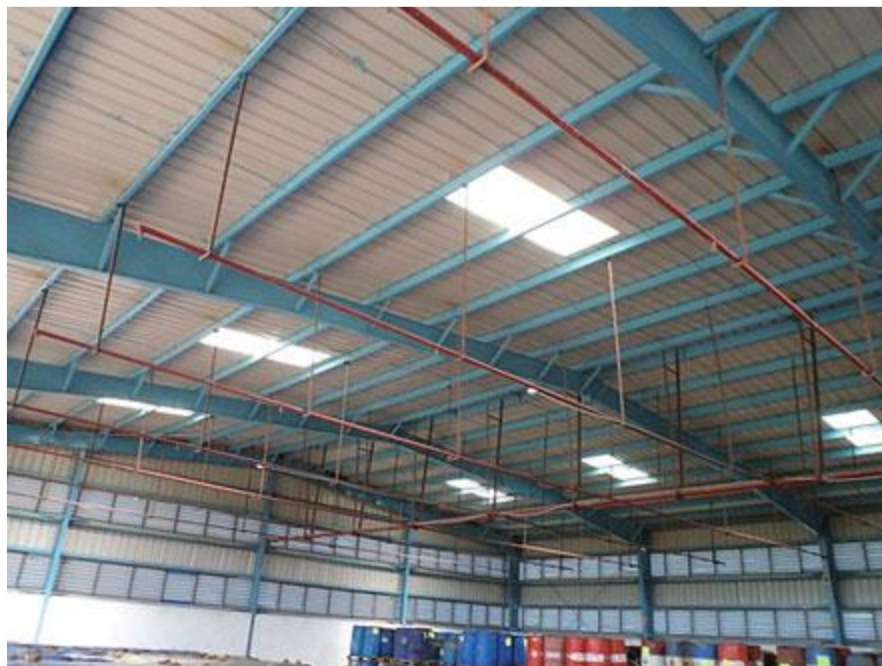
شکل ۱۱-۱۲ سیستم آب پاش در مرکز TSDF پسماند خطرناک
