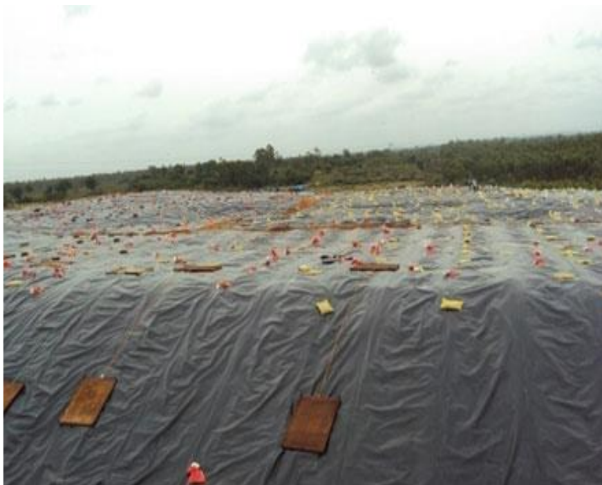
شکل ۵-۷ ژئوممبران قرار داده شده بر لندفیل قبل از بستن آن
