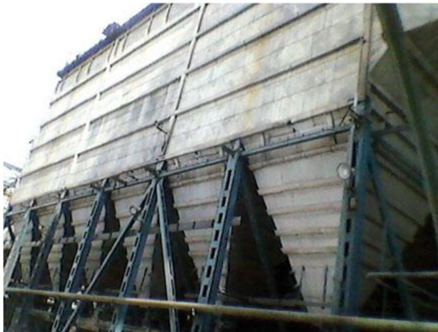
شکل ۹-۱۱ رسوب‌دهنده الکترواستاتیکی
