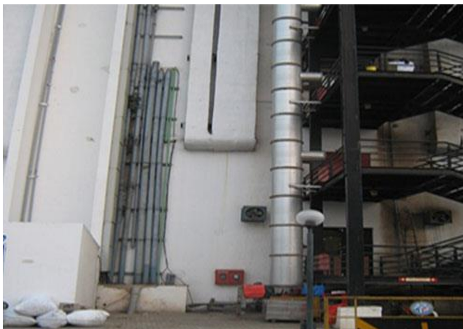
شکل ۶-۶ حامل مسیر مستقیم در بیمارستان مدرن برای انتقال پسماند از بخش‌های فردی در طبقات مختلف به محدوده انبارداری مرکزی که در آنجا گروه‌های مختلف پسماند جمع‌آوری و به موسسه معمول عملیات منتقل خواهند شد.
