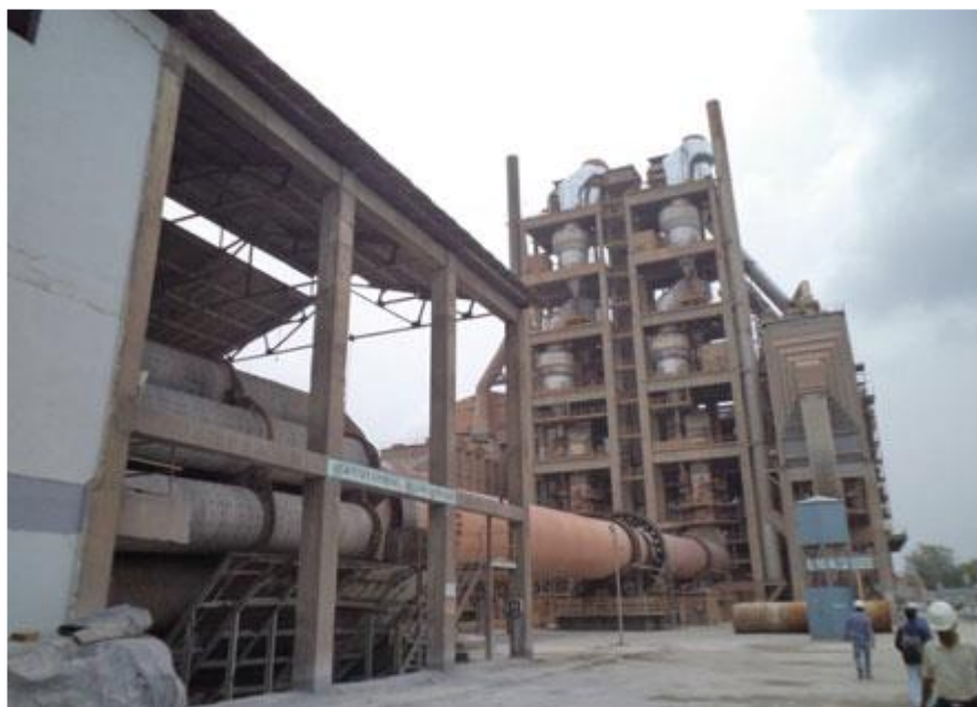
شکل ۷-۱۵ نمای نزدیک از کوره دوار
