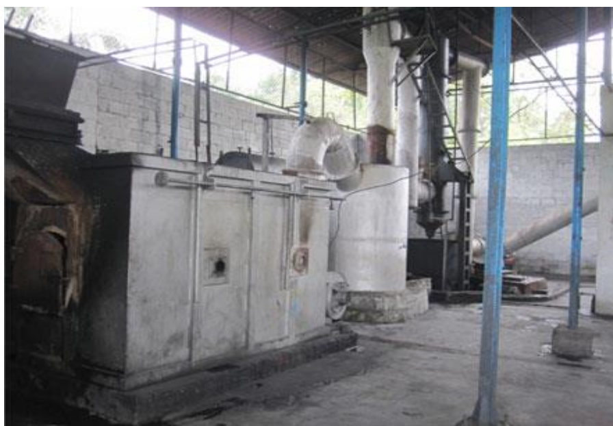
شکل ۶-۱۲ زباله‌سوز پسماند زیست پزشکی
