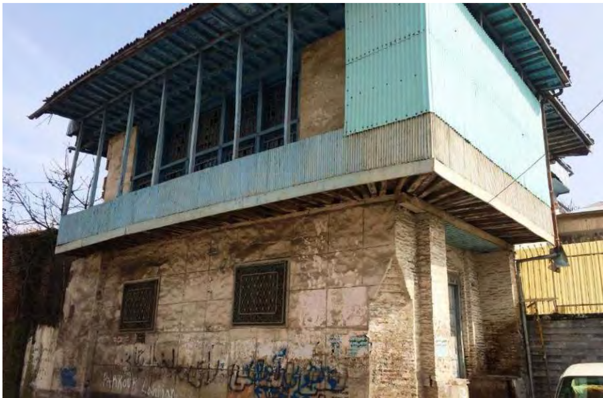
شکل ۳۷. خانه نظام شکن در محله اردوبازار که در آن علاوه بر روی سردر ورودی، در جداره دیگر رو به معبر عمومی نیز کاربرد ارسی مشاهده می شود.
