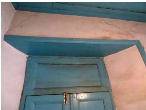
شکل ۲۱۱. نازک سازی دیوارهای میانی در طبقه بالایی خانه ها یکی از فنون تقویت ایستایی خانه ها محسوب می شده است. در این نمونه در خانه مجمع صنایع مشاهده می شود که ضخامت دیوار در حدی نبوده که یک لنگه در بتواند در حالت باز شده به طور کامل در ضخامت دیوار جای بگیرد، از این رو با ایجاد پخی امکان این کار را فراهم آورده اند.
