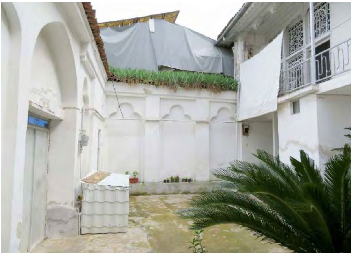
شکل ۸۷. تزئین تاقنما یا قوس سه بخشی در دیوارهای محوطه خانه فیاض در محله گابنه
