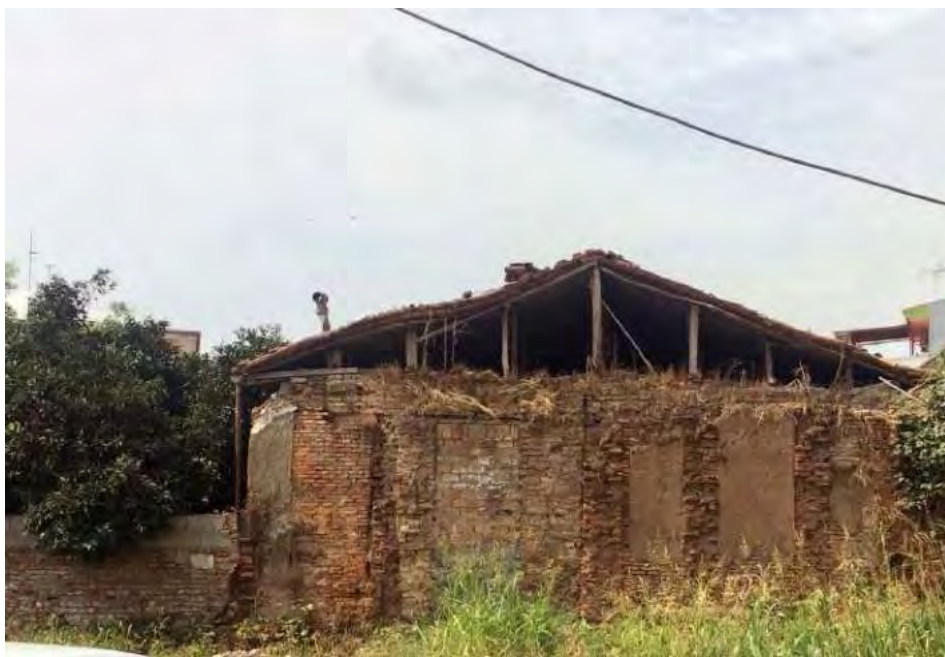
شکل ۲۱۰. نمونه ای از سازه مورد استفاده در ساخت بام شیروانی (خانه ای نیمه مخروبه در محله پرده سر)
