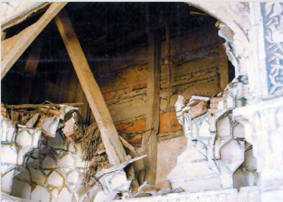
شکل ۱۴۸. تصویری از مقرنس نیمه ویران در خانه ای در محله پرده سر لاهیجان که در آن سیستم سازه ای و طناب های مورد استفاده جهت آویزان کردن تخته های مقرنس قابل مشاهده است. (منبع تصویر: آرشیو شخصی مهندس صمد مهدی پور توانا)
