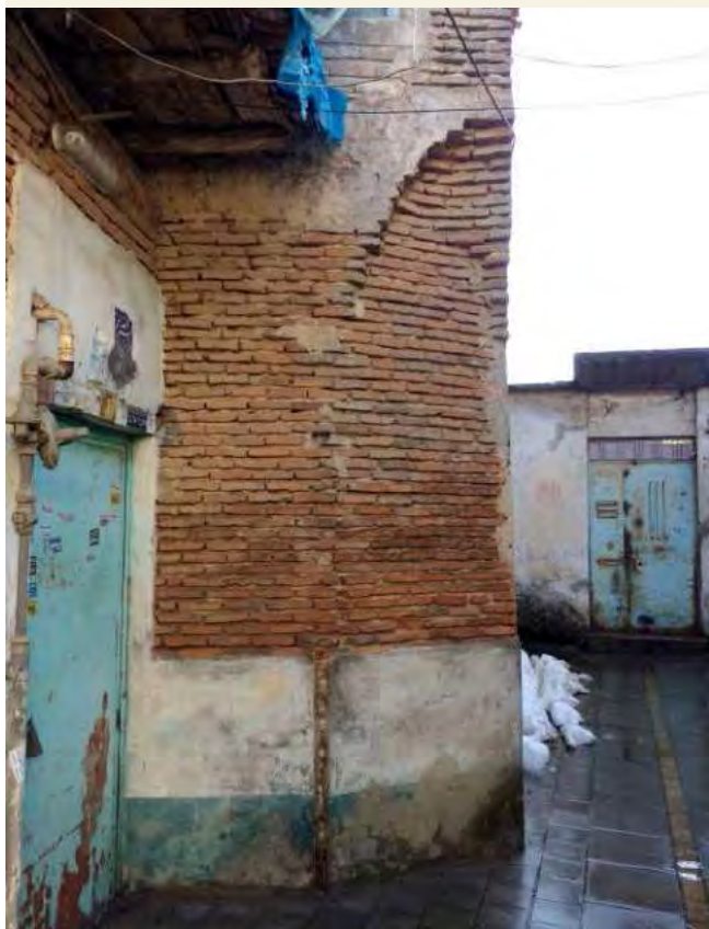
شکل ۷۸. پخ در کنج خانه ای در محله گابنه (بن بست آقا غلامحسین) که به اندازه پنج آجر پهنای دارد و از ارتفاع حدود ۵۰ رگ آجر شروع به جمع شدن می کند.
