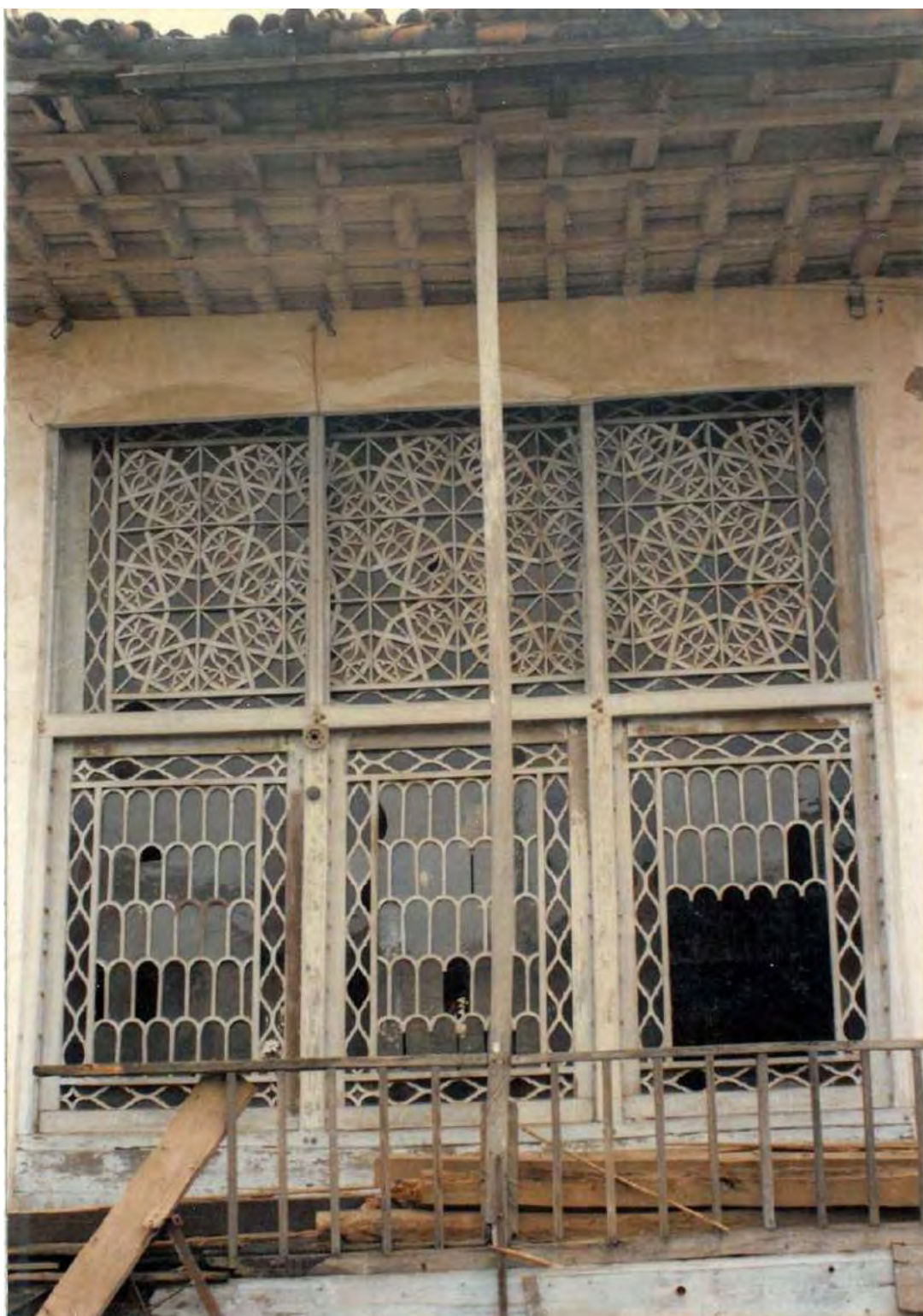
شکل ۲۰۶. نمونه ای از ارسی هایی که در آنها هم از آلت های مستقیم و هم از آلت های منحنی استفاده شده است. (منبع تصویر: آرشیو شخصی آقای مهندس صمد مهدی پور توانا)
