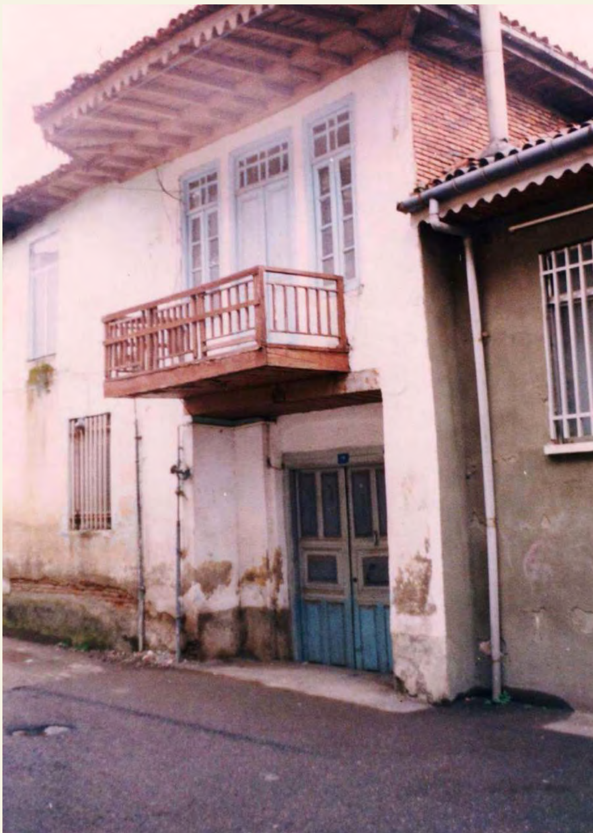
شکل ۳۴. نماسازی اتاق واقع بر دروازه ورودی می توانسته به کمک در و پنجره معمولی هم انجام شود.
