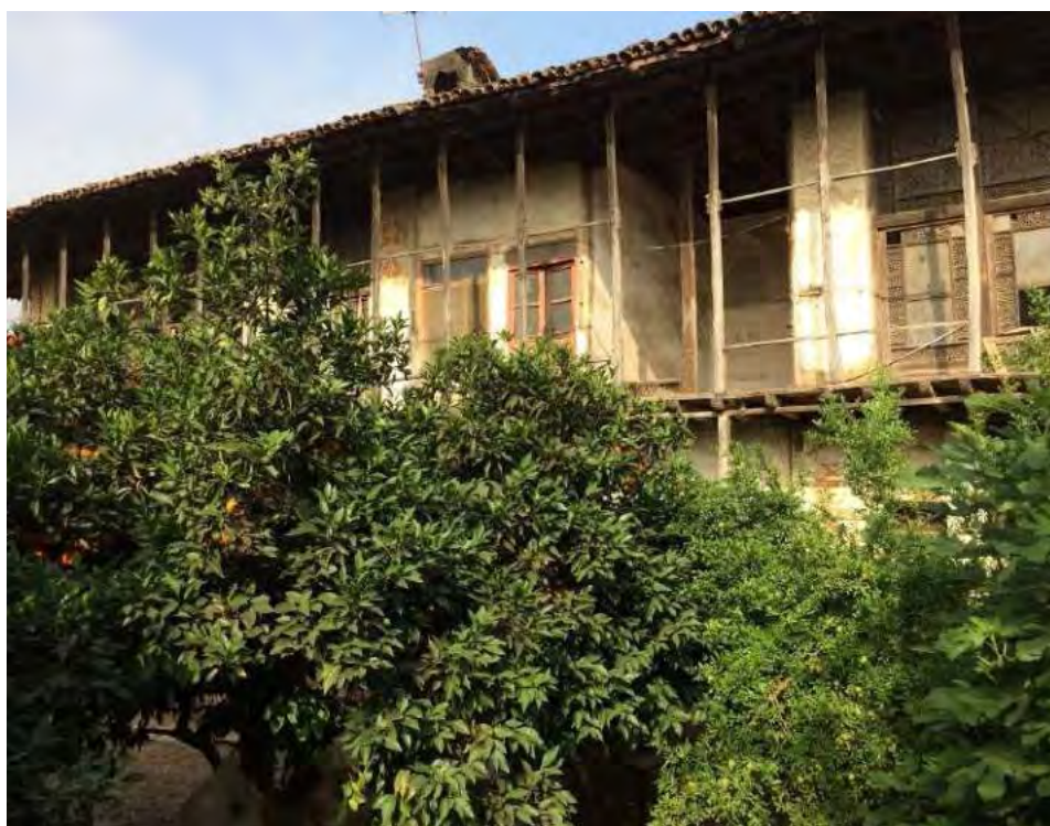
شکل ۱۹۱. در اغلب بناهای قاجاری لاهیجان لایه هایی که یکی بعد از دیگری به نمای ساختمان شکل می دهند، تحت یک انتظام کلی با یکدیگر هماهنگ سازی نمی شوند، بلکه هر یک به طور مستقل طراحی می شوند. در نمای خانه دوزنده لایه ستون های تالار و لایه جداره اتاق ها مستقل از یکدیگر طراحی شده اند.
