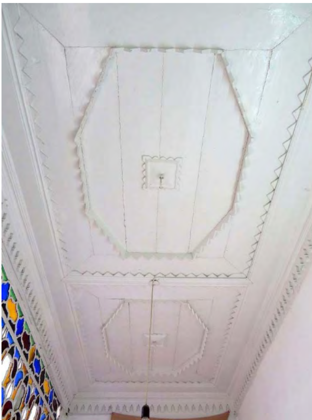
شکل ۱۴۹. لمبه کوبی مزین در سقف داخلی خانه فیاض
