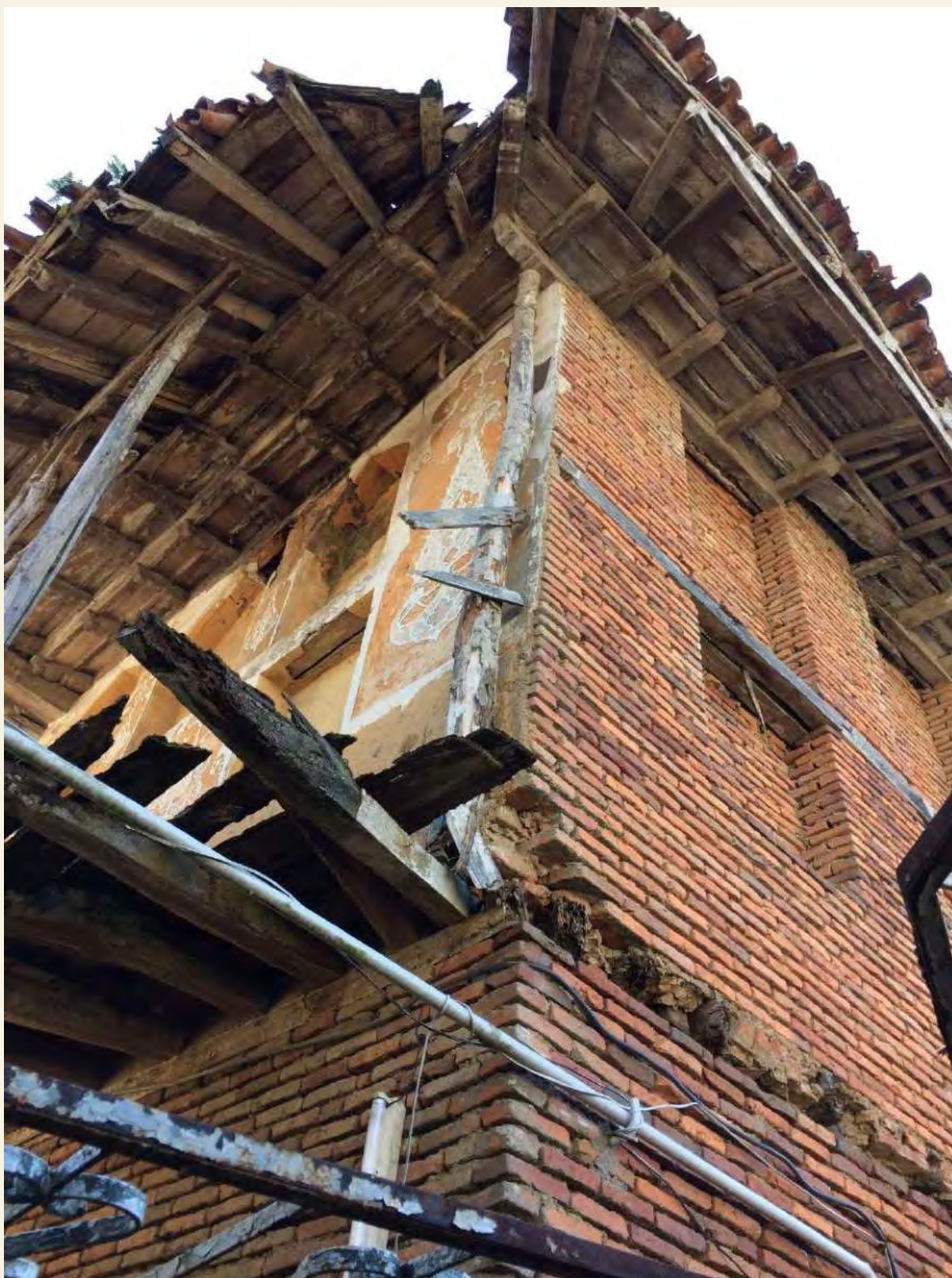
شکل ۱۳۴. تصویری از دیوار پشتی و تالار جانبی خانه دوزنده: در معماری خانه های قاجاری لاهیجان، نظام تاقچه بندی اتاق ها به خوبی با سیستم سازه ای و روش های سبک سازی ساختمان به خصوص در طبقه اول خانه ها ترکیب یافته بود.
