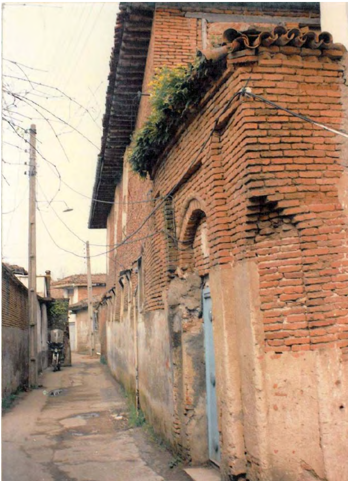
شکل ۷۹. پخی در کنج دیوار محوطه خانه ای در محله گابنه (کوچه منتهی به خیابان سردار جنگل) (منبع تصویر: آرشیو شخصی آقای مهندس صمد مهدی پور توانا)
