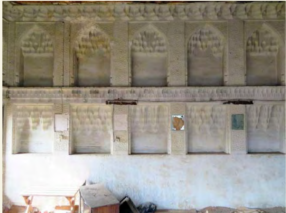
شکل ۱۳۷. تاقچه بندی اتاق مهمان در خانه دوزنده همچون عامل اصلی تعیین نظم فضایی در طراحی داخلی عمل نموده است.
