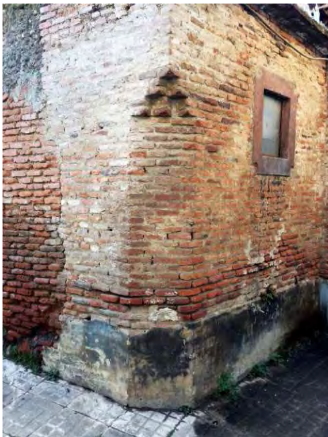
شکل ۷۷. پخی در کنج دیوار محوطه خانه شکوری (نبش کوچه شریعت زاده در محله گابنه) که ارتفاع آن کمی بیش از قد یک نفر آدم متوسط (۳۶ رگ آجر) و پهنای آن دو و نیم آجر است.
