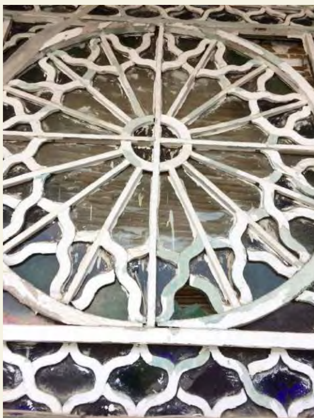
شکل ۲۰۲. بخشی از اِرسی خانه صفارنیا با آلت های عمدتاً منحنی الخط
