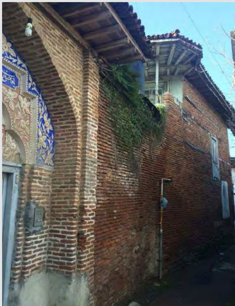
شکل ۷۴. ارتفاع خانه راستگو در مجاورت معبر با احداث یک اتاق به دو طبقه رسانده شده، در حالی که بقیه خانه در یک طبقه ساخته شده است.
