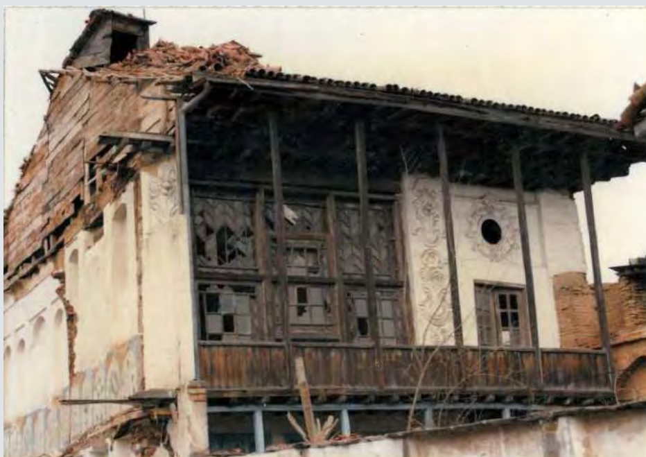
شکل ۱۶۳. در این خانه سطح نرده خور تالار به کمک تخته کاملاً مسدود شده است. (منبع تصویر: آرشیو شخصی مهندس صمد مهدی پور توانا)
