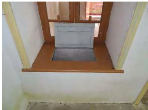
شکل ۱۴۳. نمونه ای از کمد دیواری موسوم به شکاف که در زیر پنجره ها کار می‌شد در خانه طاهرپور
