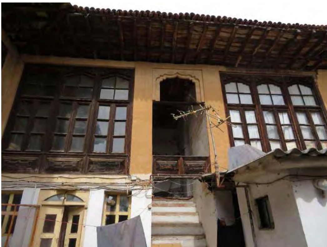
شکل ۱۶۹. در خانه بریسم حقیری الگوی پله در وسط و دو اتاق در طرفین به کار رفته است.
